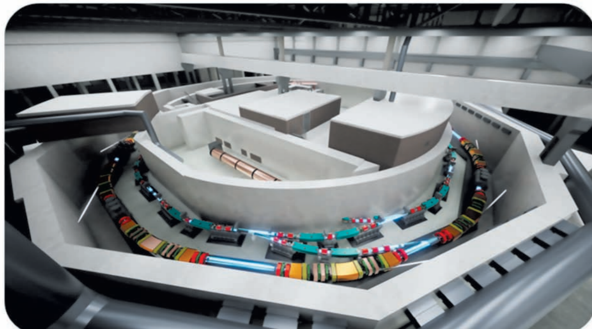
Рисунок 4.5. – 3D модель большого накопителя и бустерного синхротрона «КИСИ-Курчатов» после модернизации
